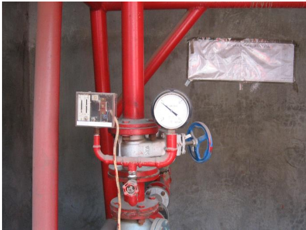
Gambar 2. Pressure gauge pada Reservoir Tekan Pipa Hydrant
