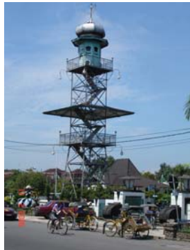
Menara mesjid Demak. Dibangun dengan konstruksi baja pada Th. 1924, sebagai pengganti menara kayu yang sudah rusak.
